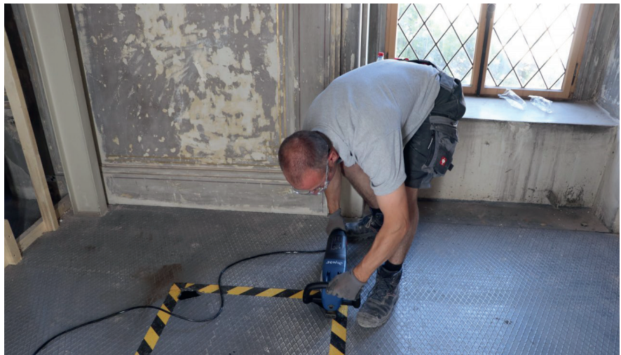
Der Ablauf beim Entfernen der rund 320 m 2 Stahlbleche ist in allen Stockwerken gleich ... © Trumpf
