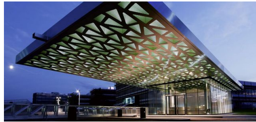
2016 hat der Ditzinger Campus beim Industriepreis in der Kategorie „Städtebauliche Anlagen“ das Rennen gemacht. Hier zu sehen: Das Pförtnerhäuschen.
