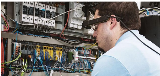
In den USA haben TRUMPF Kunden die Möglichkeit, bei technischen Problemen Smart-Glasses zu nutzen, um Reparaturen zu beschleunigen. Einmal eingeschaltet, sendet die Brille automatisch ein Echtzeit-Video an erfahrene Service-Techniker, die damit dasselbe sehen wie der Kunde und so das Problem gemeinsam lösen können.
