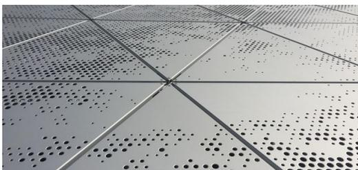
Jedes der rund 37.000 Paneele ist ein Unikat. Die Verteilung der Löcher wurde mit Hilfe eines eigens entwickelten Algorithmus erstellt. (Quelle: © A. ZAHNER COMPANY)
