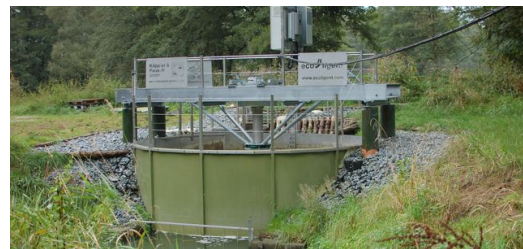
Die tragenden Elemente des fischfreundlichen Wehres werden komplett auf einer TruLaser Tube 7000 gefertigt. Bild: Jan Gutzeit
