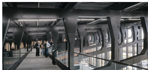
<p>Elf Stahlprofile, aus Einzelstücken geschweißt, tragen das Dach der Produktionshalle der TRUMPF Smart Factory in Chicago, USA. (Quelle: TRUMPF)</p>
