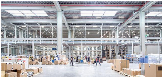
Das neue TRUMPF Logistikzentrum hat eine Grundfläche von 13.000 Quadratmetern, 18 Meter hohe Decken – und liefert jeden Monat mehr als 60.000 Artikel aus. Bild: Claus Morgenstern
