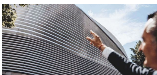
Un estadio brillante: Lasercor cortó más de la mitad de las casi 9000 láminas fabricadas para la espectacular envolvente del Estadio Bernabéu con precisión milimétrica.
