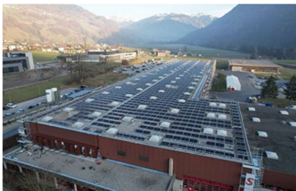
Die installierte Photovoltaikanlage auf dem Dach der Montagehalle der TRUMPF Schweiz AG in Grüşch
