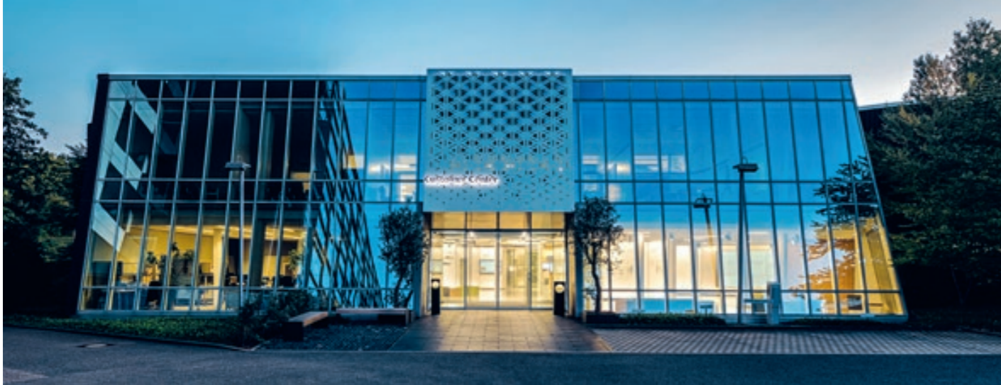
Centro de atención al cliente: una bonita arquitectura industrial combinada con la gran calidad de los productos aspira a convencer a los clientes de TRUMPF.
