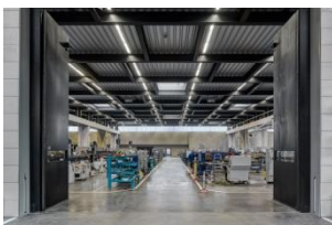
Blick in die neue Produktions- und Montagehalle in Neukirch
