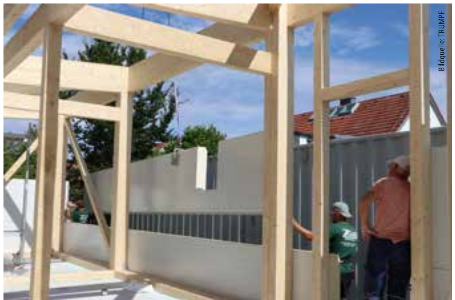
... passgenau mit einem Kran aufeinander und fixierte sie an der Holzkonstruktion.
