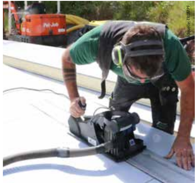
Eine Führungsschiene hilft dabei, einen maßgenauen Schnitt in die Sandwichpaneele zu setzen. Da das Schwert im rechten Winkel steht, stimmt der Schnitt im oberen und unteren Blech bis zu einer Materialstärke von 165 mm genau überein.
