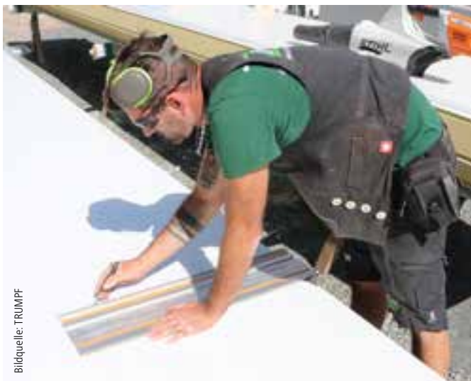
Polier Mathias Schmitt zeichnet auf der Baustelle den geplanten Ausschnitt an. Anschließend kann er das stabile Schwert des Cutters mit mäßig starkem Druck an jeder beliebigen Stelle maßgenau und ohne Startlochbohrung in das Paneel eintauchen.
