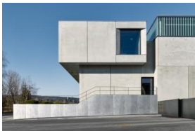
Kopfbau der Produktions- und Montagehalle in Neukirch
