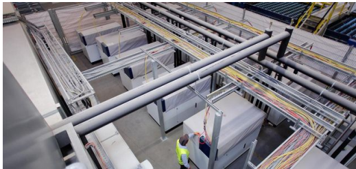
Zwölf Hochleistungslaser erzeugen 144 Kilowatt Leistung. Bild: Ralf Kreuels
