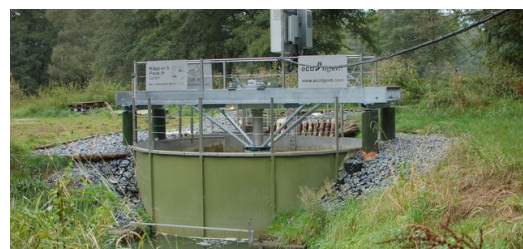
Die tragenden Elemente des fischfreundlichen Wehrs werden komplett auf einer TruLaser Tube 7000 gefertigt. Bild: Jan Gutzeit
