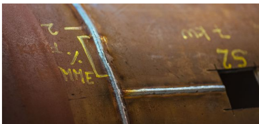
Nähte mit einer Schweißtiefe von bis zu 25 Millimeter: Mit einem 32-Kilowatt-Laser simulieren die Ingenieure des LWT Laserhybridschweißprozesse für die maritime und Offshorewindkraftindustrie. Foto: Kasper Fladmose
