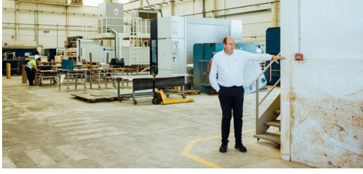
<p>José Giner böyle hatırlıyor: Sel felaketinden sonra üretim tesislerindeki su ve çamur bu seviyedeydi.</p>
